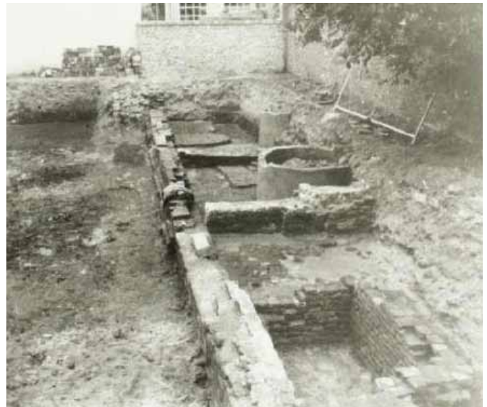
Afb. 38: De huisjes aan de Kranensteeg.
