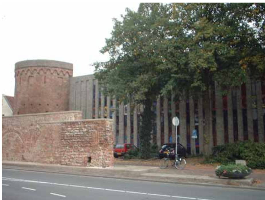
Afb. 10: Foto gymzaal aan de Achter de muren Vispoort.
