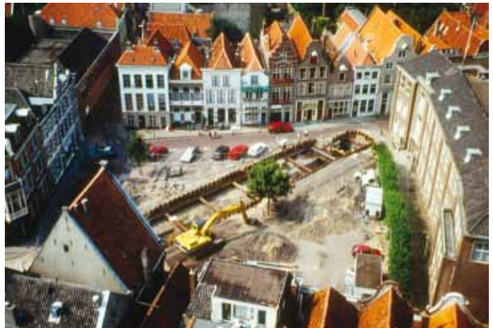
Afb. 31: De rioolsleuf op de Nieuwe Markt.
