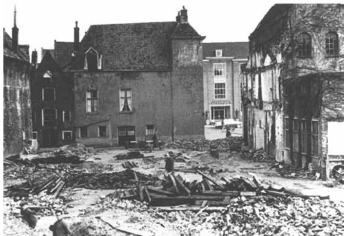
Afb. 23: Het terrein tijdens de sloop.
