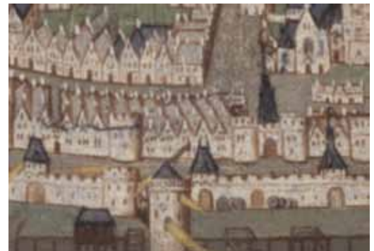
Afb. 15: De onderzoekslocatie op het schilderij van het beleg van Rennenberg (ca. 1578)
