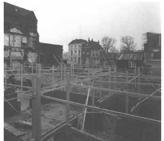
Afb. 26: De nieuwbouw in 1964.
